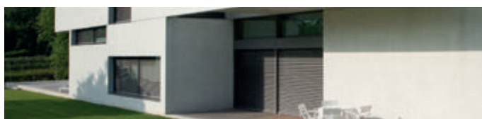
PORTONES ELÉCTRICOS EN COCHERA
